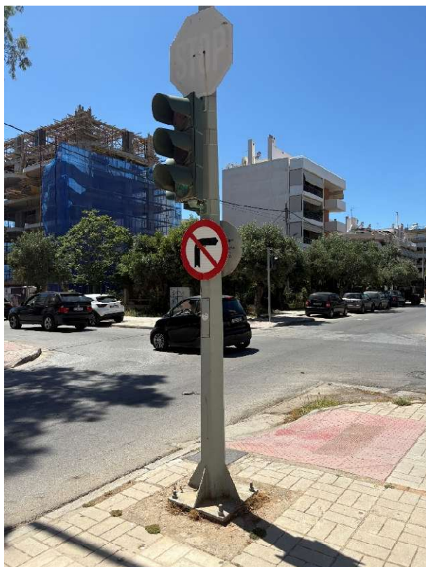
Εικόνα 4.67 «Εμπόδιο επί της ζώνης όδευσης & ράμπες ΑμεΑ»
