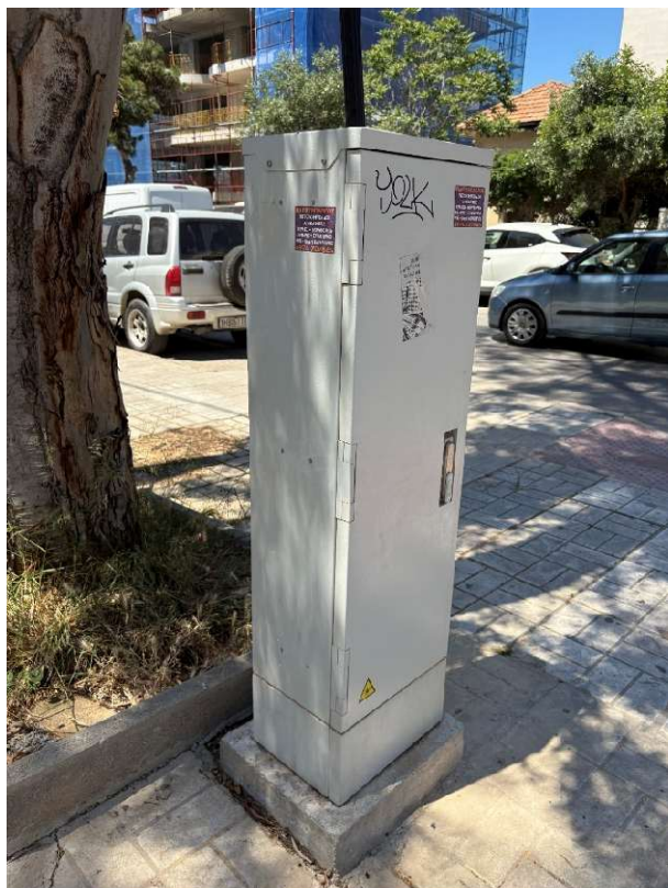
Εικόνα 4.23 «Εμπόδιο επί της ζώνης όδευσης, που επηρεάζει την πορεία των πεζών»
