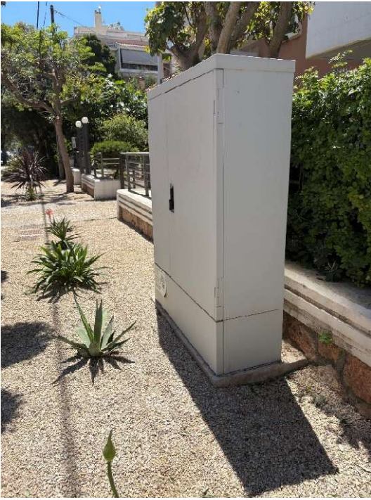
Εικόνα 4.17 «Εμπόδιο επί της ζώνης όδευσης, που επηρεάζει την πορεία των πεζών»
