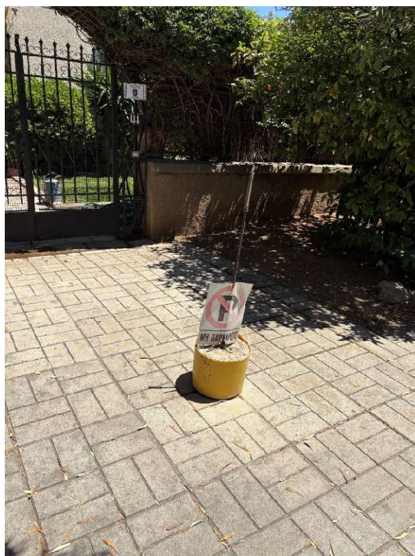
Εικόνα 4.36 «Εμπόδιο επί της ζώνης όδευσης, που επηρεάζει την πορεία των πεζών»
