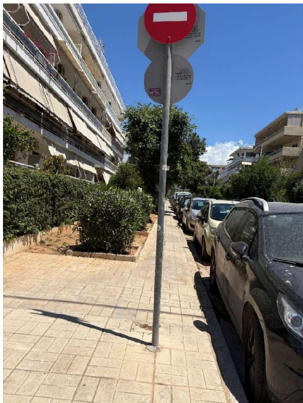
Εικόνα 4.41 «Ακατάλληλη χωροθέτηση φύτευσης & Εμπόδιο επί της ζώνης όδευσης»
