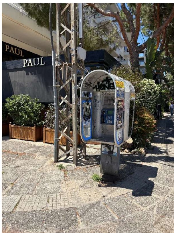
Εικόνα 4.63 «Εμπόδιο επί της ζώνης όδευσης & φθορές κρασπέδων»
