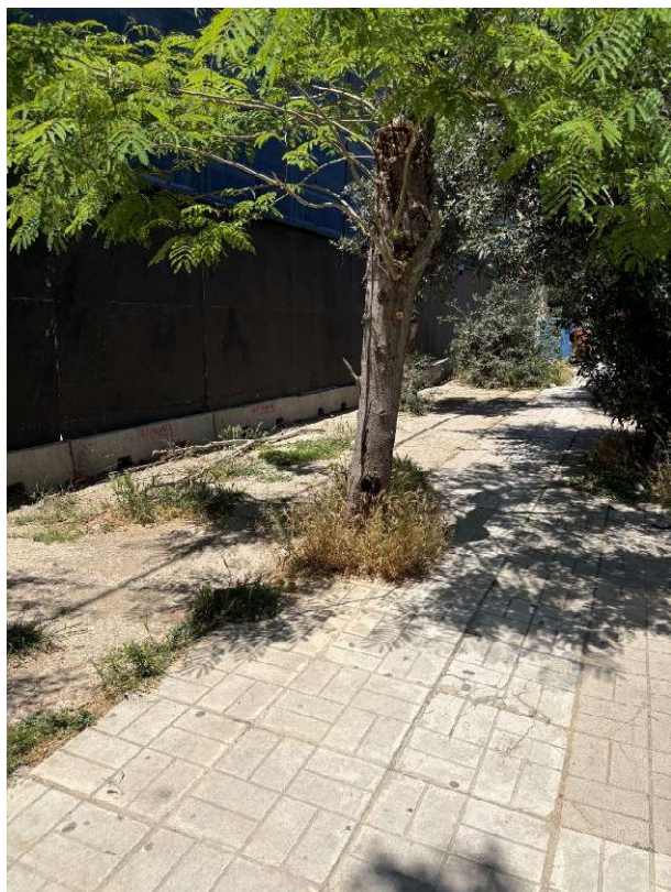
Εικόνα 4.33 «Ακατάλληλη χωροθέτηση φύτευσης & προσωρινή κατάληψη του πεζοδρομίου από εργοταξιακές εγκαταστάσεις, που μειώνει την ασφαλή όδευση των πεζών»
