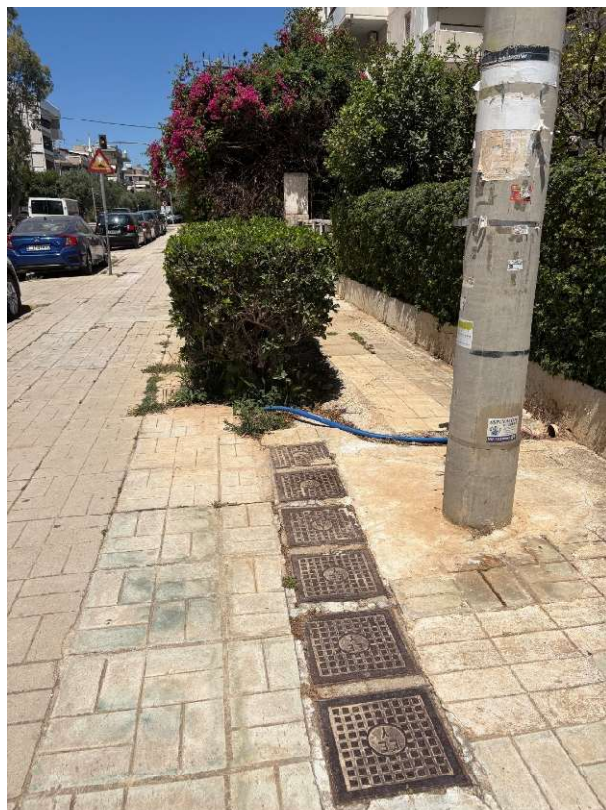
Εικόνα 4.42 «Ακατάλληλη χωροθέτηση φύτευσης & Εμπόδιο επί της ζώνης όδευσης»
