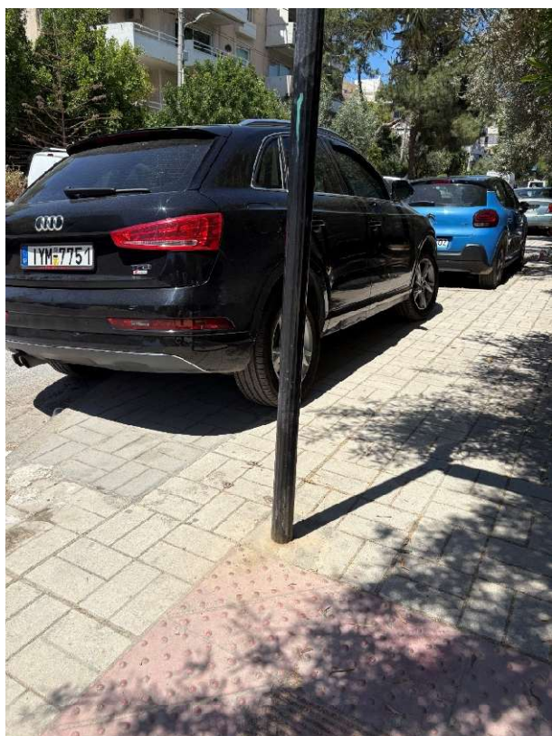
Εικόνα 4.35 «Εμπόδιο & παράνομη στάθμευση οχήματος επί της ζώνης όδευσης»
