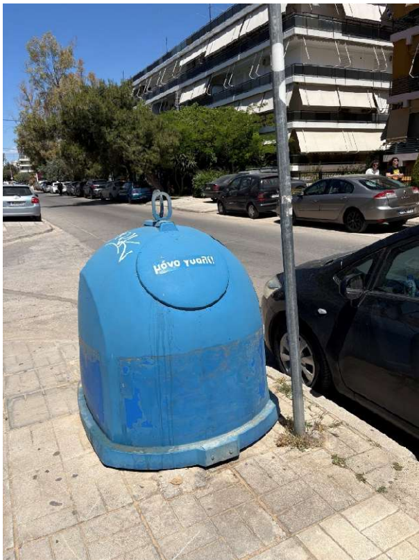
Εικόνα 4.19 «Εμπόδιο επί της ζώνης όδευσης, που επηρεάζει την πορεία των πεζών»
