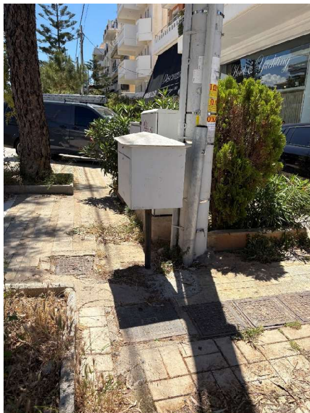
Εικόνα 4.22 «Εμπόδιο επί της ζώνης όδευσης, που επηρεάζει την πορεία των πεζών»
