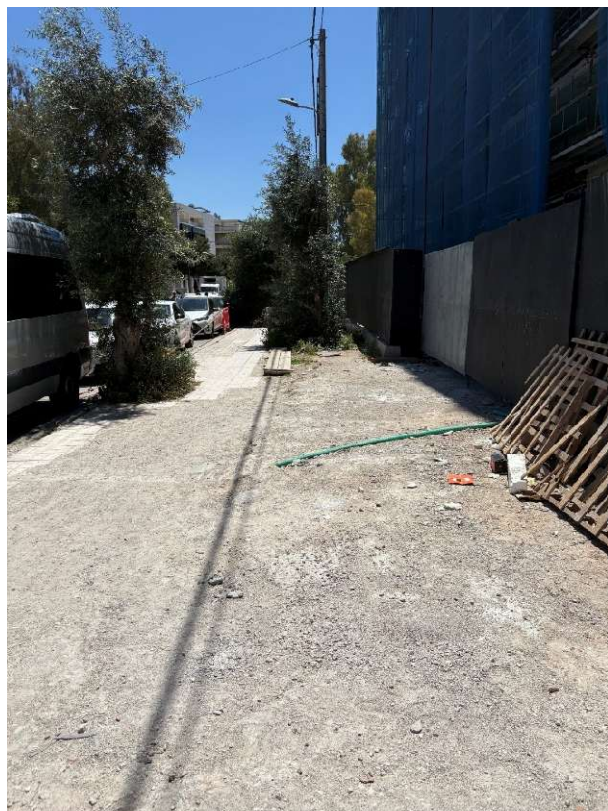
Εικόνα 4.28 «Απουσία πλακόστρωσης στην ζώνη όδευσης & προσωρινή κατάληψη του πεζοδρομίου από εργοταξιακές εγκαταστάσεις, που μειώνει την ασφαλή όδευση των πεζών»
