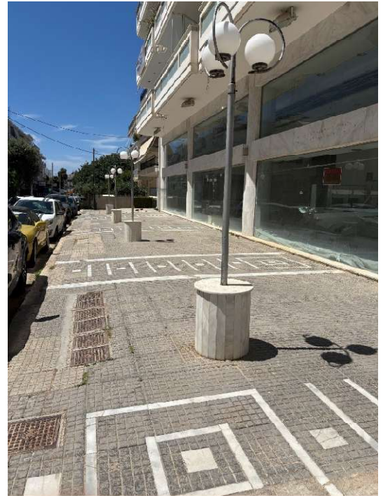
Εικόνα 4.10 «Στόλος δημοτικού φωτισμού επί της ζώνης όδευσης, ο οποίος περιορίζει την κίνηση των πεζών»
