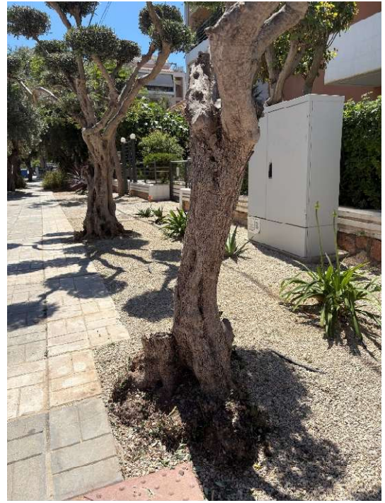
Εικόνα 4.18 «Ακατάλληλη χωροθέτηση φύτευσης & επικαλυμμένα χαλαρά αδρανή υλικά επάνω στην ζώνη όδευσης, τα οποία προκαλούν αστάθεια και υποβαθμίζουν τη βατότητα του πεζοδρομίου»
