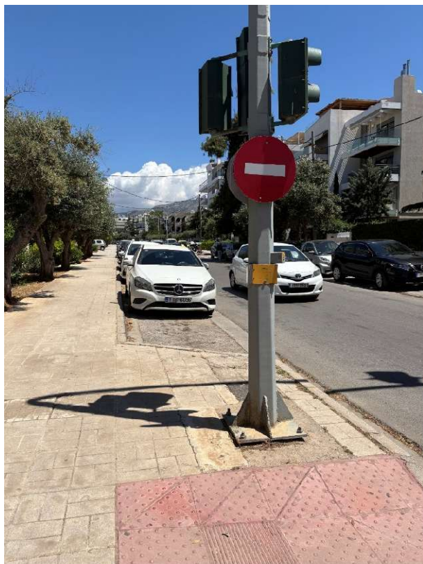
Εικόνα 4.45 «Εμπόδιο επί της ζώνης όδευσης & ράμπες ΑμεΑ»
