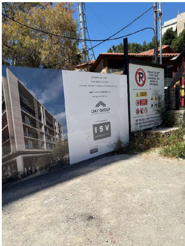
Εικόνα 4.29 «Απουσία πλακόστρωσης στην ζώνη όδευσης & προσωρινή κατάληψη του πεζοδρομίου από εργοταξιακές εγκαταστάσεις, που μειώνει την ασφαλή όδευση των πεζών»
