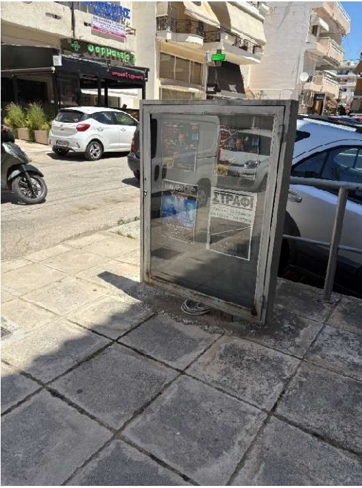
Εικόνα 4.9 «Εμπόδιο επί της ζώνης όδευσης, που επηρεάζει την πορεία των πεζών»
