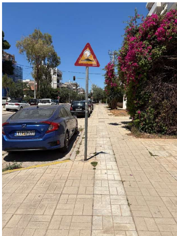
Εικόνα 4.44 «Ακατάλληλη χωροθέτηση φύτευσης & Εμπόδιο επί της ζώνης όδευσης»
